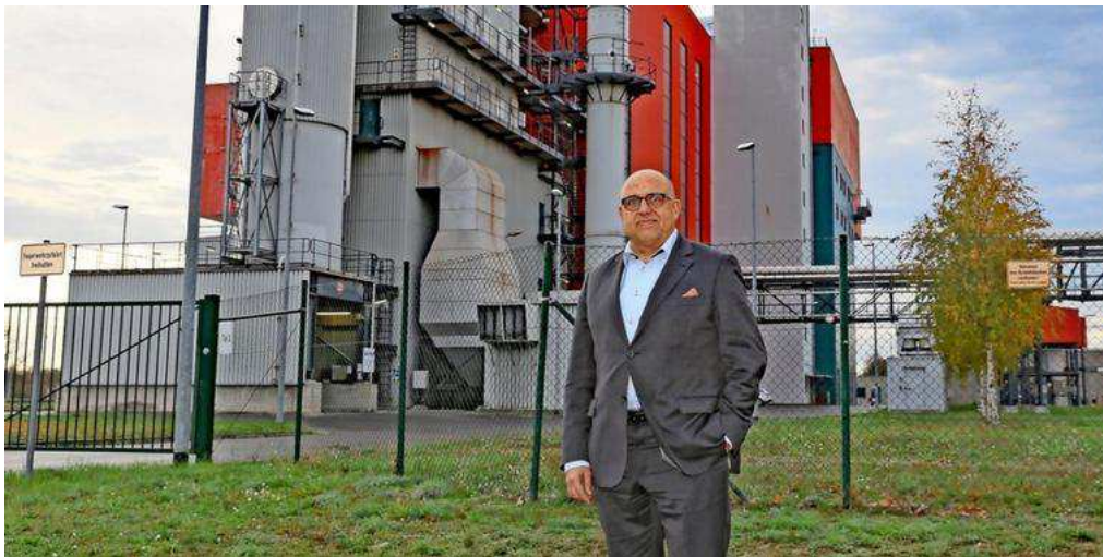
Thomas Obermeier vor der EEW-Anlage in Premnitz. Quelle: Bernd Geske
